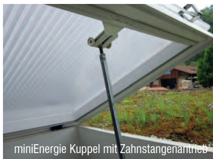
Stegplatten-Einsatz in einer Lichtkuppel
